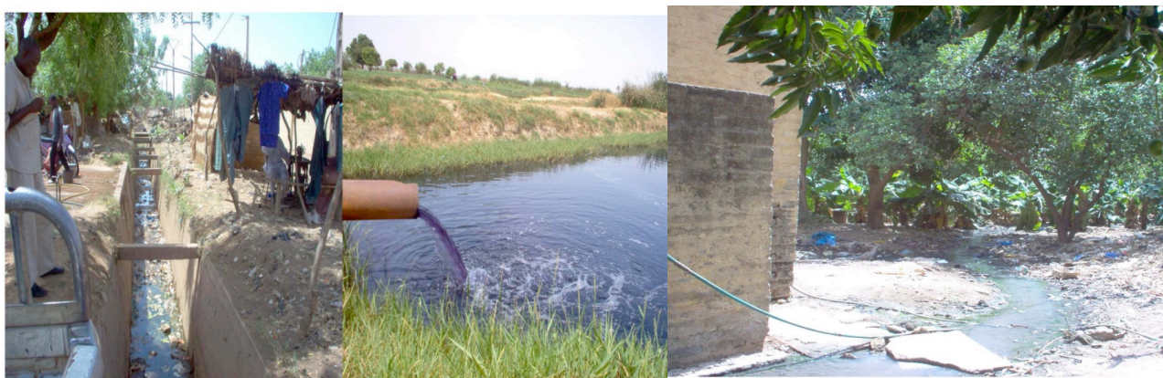
Figure 18: Déversement d'eaux usées dans le caniveau et dans un cours d'eau et d'épandage d'eaux usées sur le sol
