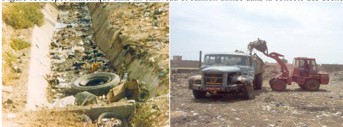
Figure 15: Dépôt anarchique dans un caniveau et camion utilisé dans la collecte des déchets
